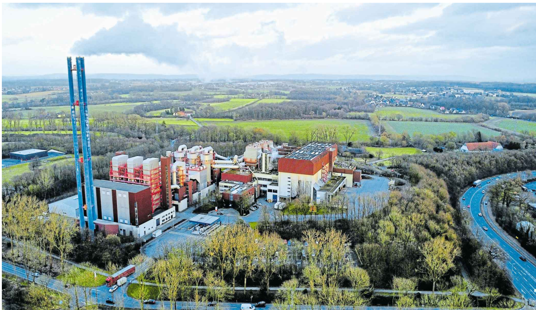
Von der MVA in Heepen soll über die Eckendorfer Straße (rechts im Bild) eine Fernwärmeleitung bis zur Feldstraße neu gebaut werden.
